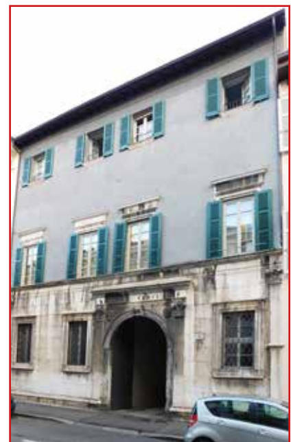
11. Palazzo Porcellaga, via Cairoli n. 5, Brescia
