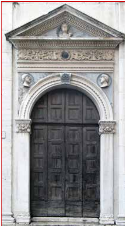
10. Palazzo della Loggia, Brescia, portale dello scalone
