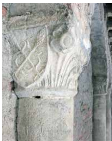
Fig. 5 Il portico in direzione sud.
