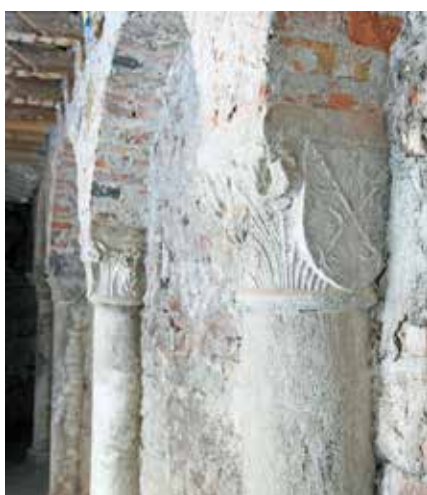
Fig. 4 Il portico in direzione nord.
