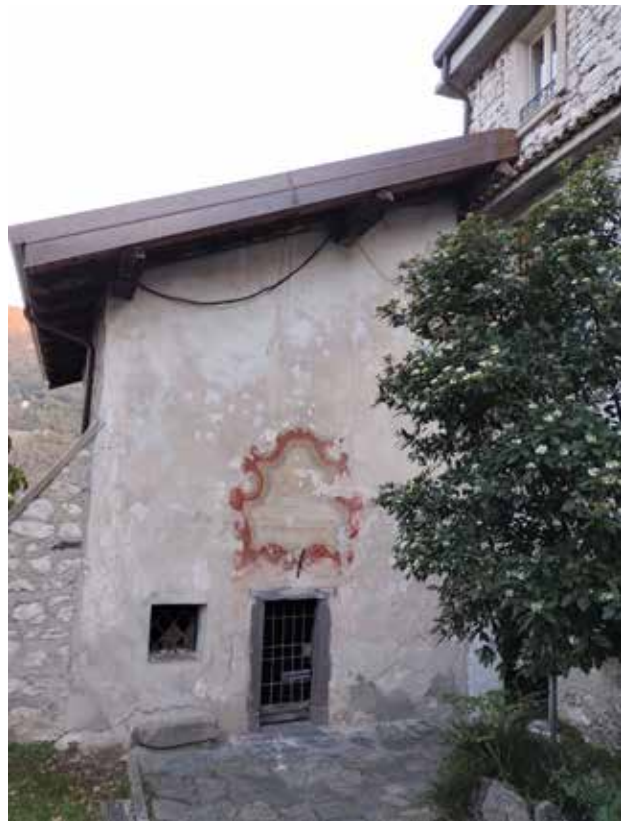
A 6: L'ingresso nella seicentesca cappella che conteneva le statue lignee della Deposizione nel Sepolcro o Compianto sul Cristo morto .
