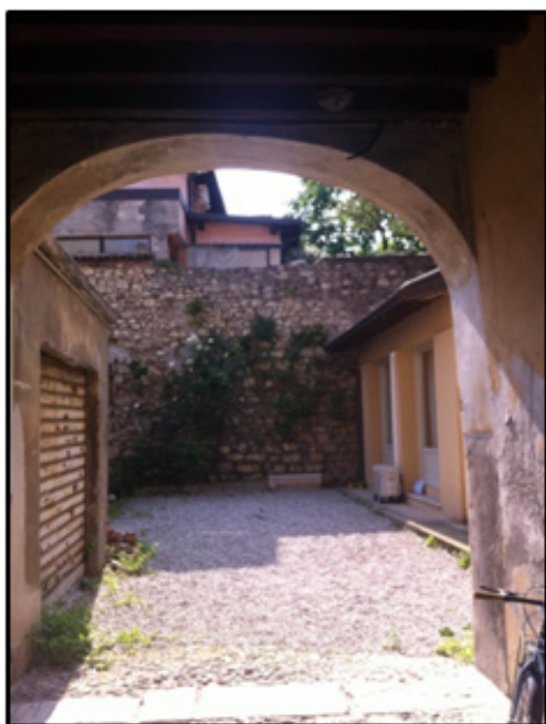
Resti delle mura della prima cinta comunale (corso Mamelì e in via Battaglie)
